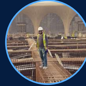
Ruşen Dağparçası İnşaat Mühendisi
