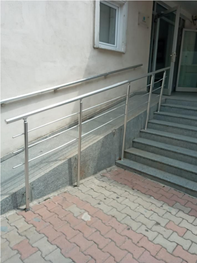
F Blok giriřindeki engelli rampası
