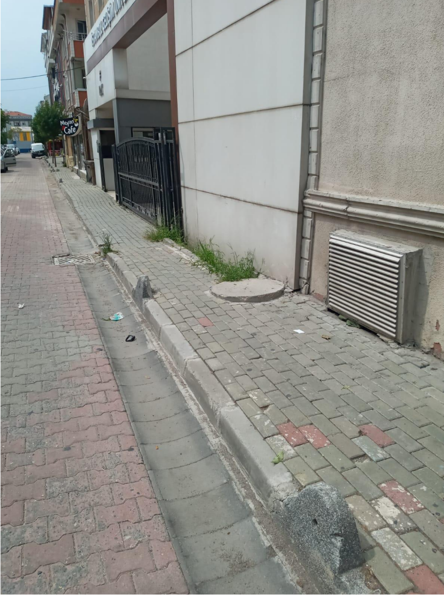
F Blok Enstitü Binası girişi
