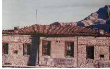
Şekil 3.15. İspidalya Binası (Erçetin, 2014)
