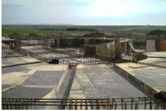
Şekil 2. Silverside Hotel'in İnşaat Dönemi (SHA, 2011)
