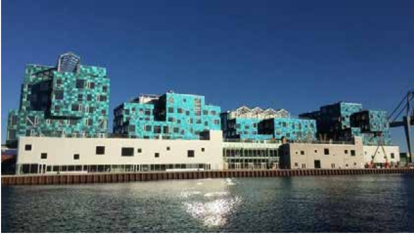
Şekil 9. Kopenhag Uluslararası Okulu cephede kullanılan güneş panelleri (Gibson, 2017)
