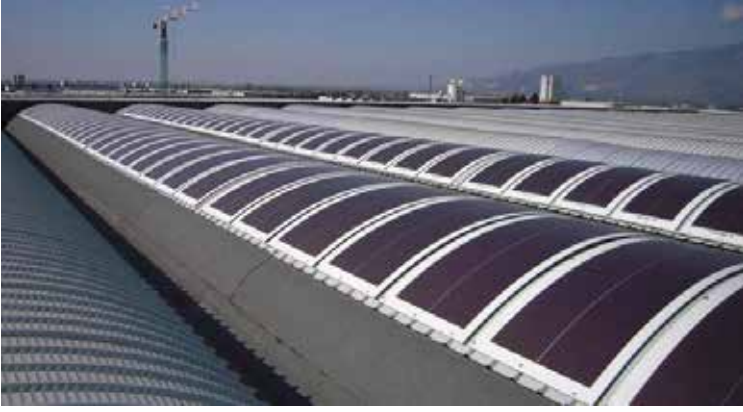
Şekil 1. İnce Film güneş paneli eğrisel çatıda kullanımı (Demircan, 2016).
