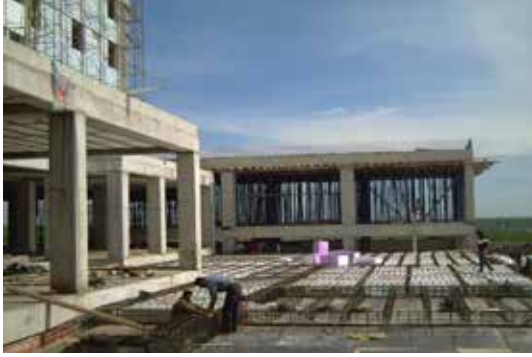
Şekil 3. Silverside Hotel'in İnşaat Süreci (SHA, 2011)
