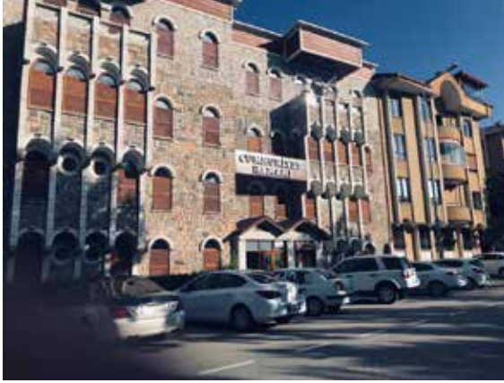
Şekil 3.24. Cumhuriyet Hamamı ön cephe görünüş (Akdağ, 2020)
