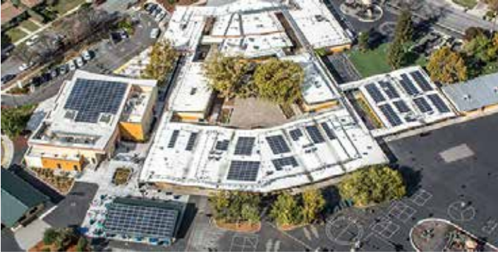
Şekil 6. Castlemont İlköğretim Okulu çatıda güneş panelleri (Url-7, 2019).
